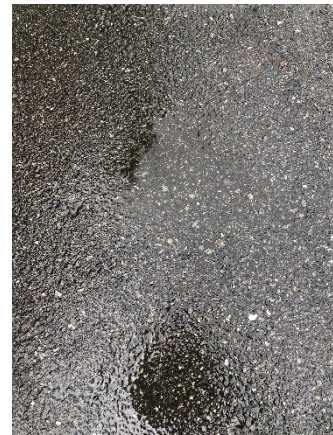
アスファルト の地面の様子
