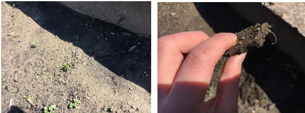
写真（12）雨が止んだ後におけるコンクリートの壁との境の部分に水が溜まっていた場所での地面の様子(左)と土の様子(右)
