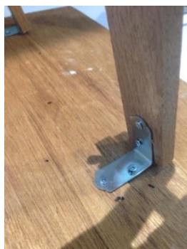
写真 5 : L 字金具の固定部分
