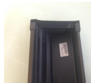
写真 3 2 : 角止まりの接合部
